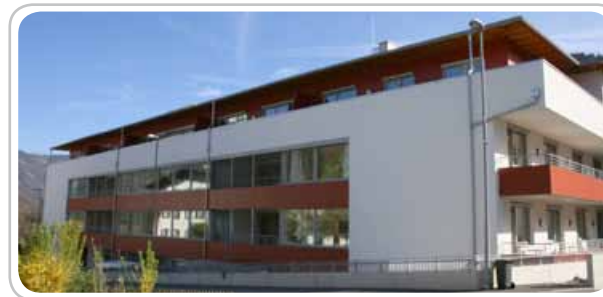
Brixlegg Haus der Generationen
